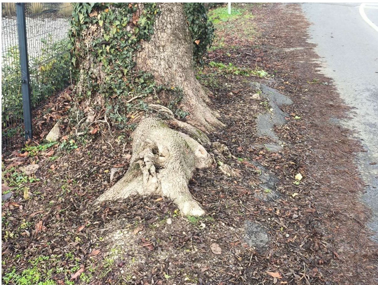
Feltorlódott gyökér, ami korhadása okán rejtett úthibát generálva kátyúsodást okoz
