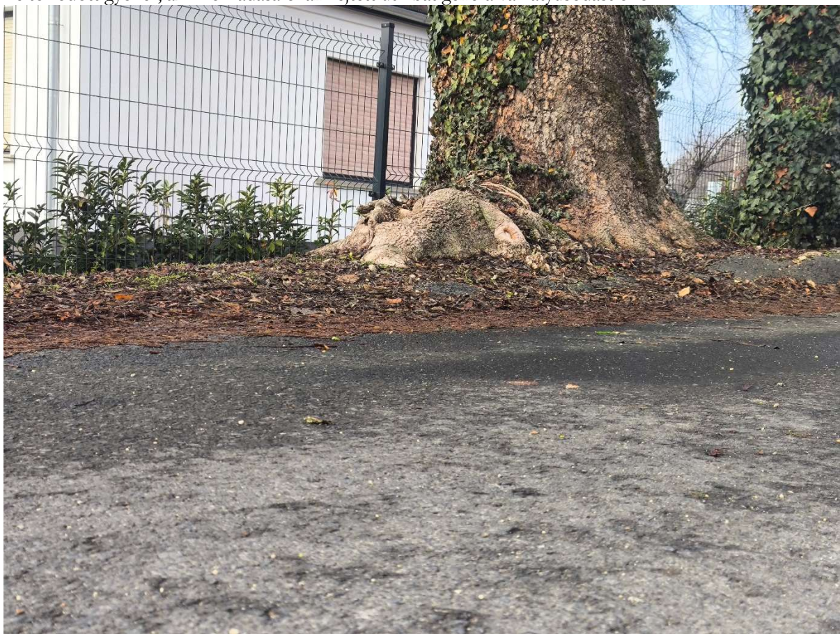
Feltorlódott gyökér, ami korhadása okán rejtett úthibát generálva kátyúsodást okoz
